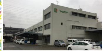
ケーエスケー尼崎支店
